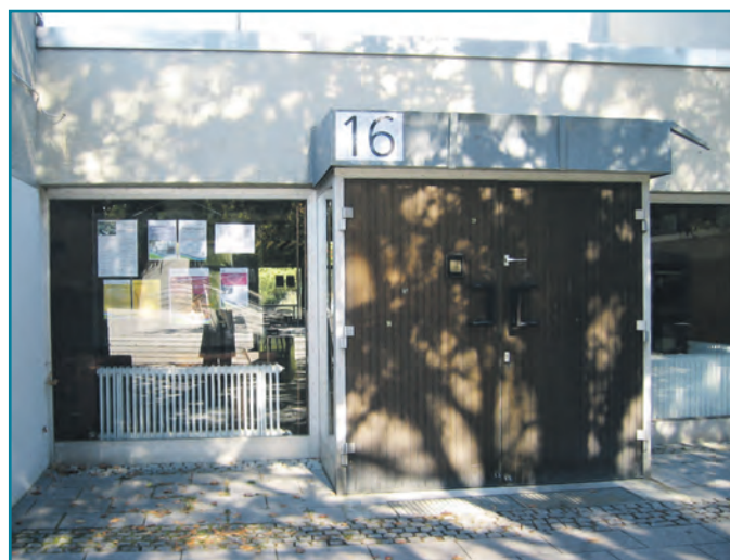
Geschlossene Türen - sieht es bald immer so aus?
