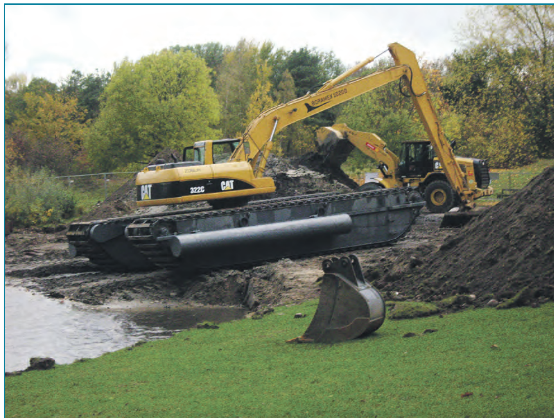
Mit schwerem Gerät wird Bauschutt aus den 70er Jahren aus dem Großen Spektensee gebaggert.
