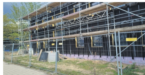
Der eingerüstete Bereich 1, - © Gudrun Meier
